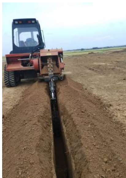
Vis sans fin Évacuation des terres sur chaque bord de tranchée
