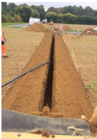
Vis sans fin Évacuation des terres sur chaque bord de tranchée
